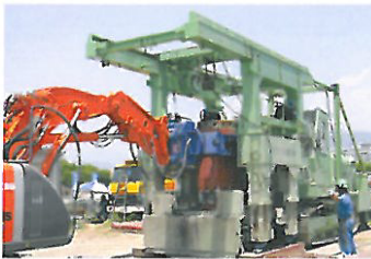
6 鉄筋かご建て込み・ジョイント
